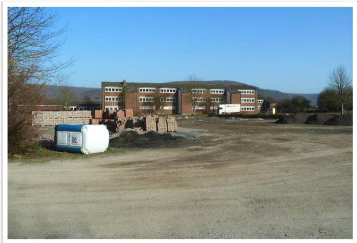
Teilbereich 1 mit den östlich angrenzenden 3-geschossigen Gebäude der Grundschule (Foto: Ing.-Büro Wenning 2021)
